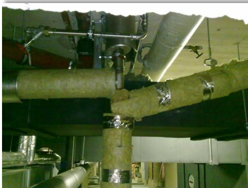
Figure 32. Isolation des conduites par de la laine minérale, avec pente pour récupération de condensat
