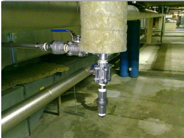
Figure 33. Purgeur thermostatique pour l'évacuation des condensats
