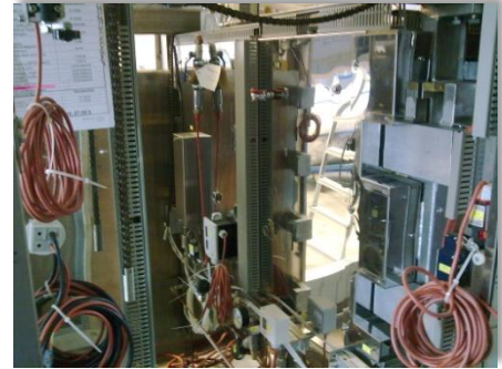
Figure 26. Chambre nue, prête au montage
