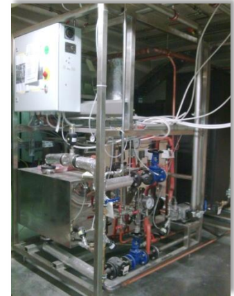
Figure 31. Echangeur vapeur à l'étage technique
